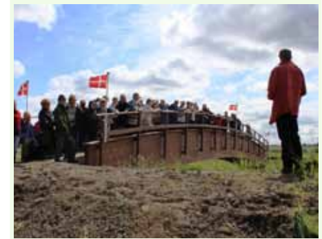
Små og store projekter er en del af indsatsen. Billedet her er fra indvielsen af Hagested Bro.
